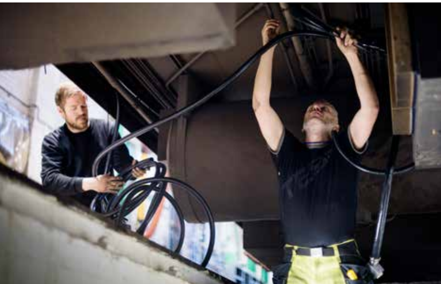
KABLER: Mye arbeid har skjedd under vognene, blant annet for å sikre kraftigere strømtilførsel. Her er Paul Schiager og Ståle Stenhaus fra Mantena i arbeid under F7-en, det vil si regi-vogna.
