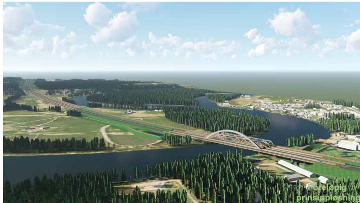
... ELLER TO BRUER MED FYLLING? Prosjektet gjennomfører omfattende grunnundersøkelser for både pæling og eventuell fylling .
