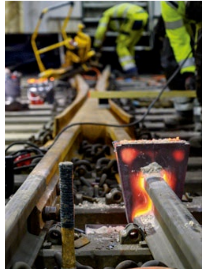
3000 GRADER: Skinnesveisen er straks klar til å bli klippet av med hydraulisk verktøy. Deretter følger sliping og finpuss med vinkelsliper.
