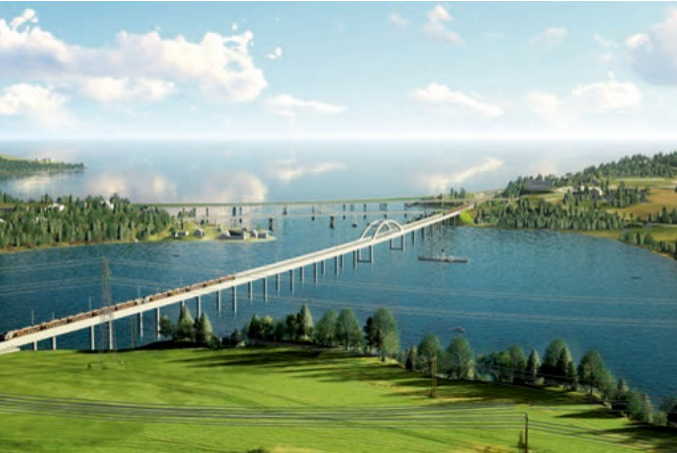
15 METER HØY: Nye Minnevikja jernbanebru blir ikke bare Norges lengste. Hovedspennet bygges med en frihøyde på 15 meter for å sikre at verdens eldste hjuldamp, Skibladner, kan passere.
