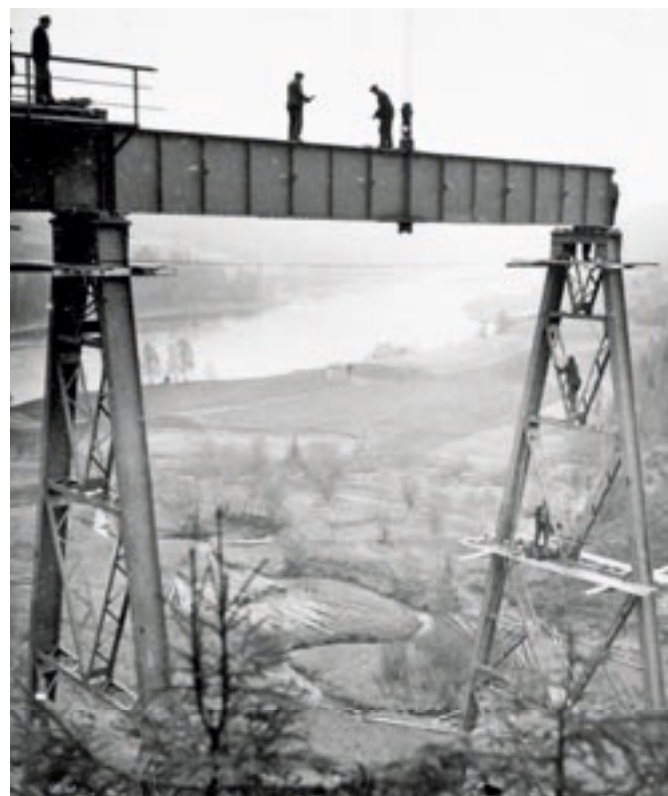
BRULAGET: Her bygges Trollaldalen viadukt som ble åpnet i 1938. Brua nord for Trøfors stasjon ble, som mange andre jernbanebruer, bygd av brulaget til NSB. Hensynet til helse, miljø og sikkerhet var tydelig ikke det samme som i dag.
