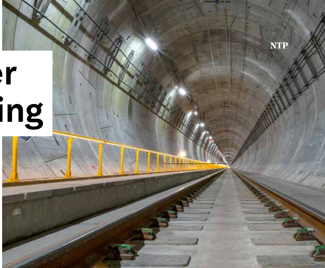
↑ TOPP MODERNE: I Blixtunnelen på Follobanen som åpner senere i år, blir nettdækningen i toppklasse. Nå vil Jernbanedirektoratet prioritere bedre nettdækning på hele jernbanenettet fram mot 2027. Foto: Øystein Grue
