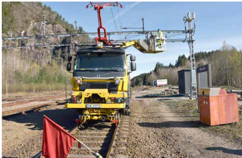
↑ BÅDE PÅ BANE OG VEG: Maskinene frå Nettpartner Bane kan køyre på både veg og bane og er fleksible i bruk ved arbeida på sørlandsbanen.
