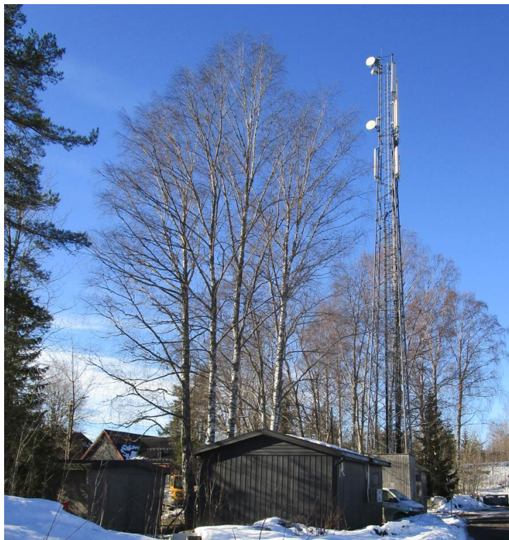
Figur 5 GSM-R mast på Nittedal stasjon (foto: Tore Mundal, Rambøll)
