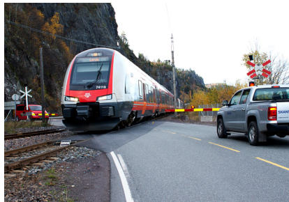
Halvbomanlegg / Half barrier
