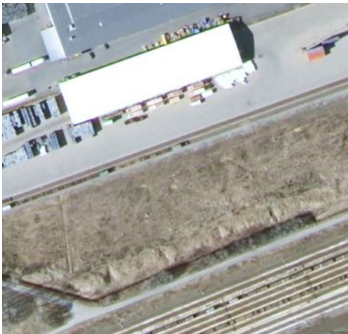
Figur V2.1:Hallsbergsterminalen – en av de två tälthallarna som används för lossning av vagnslaster
