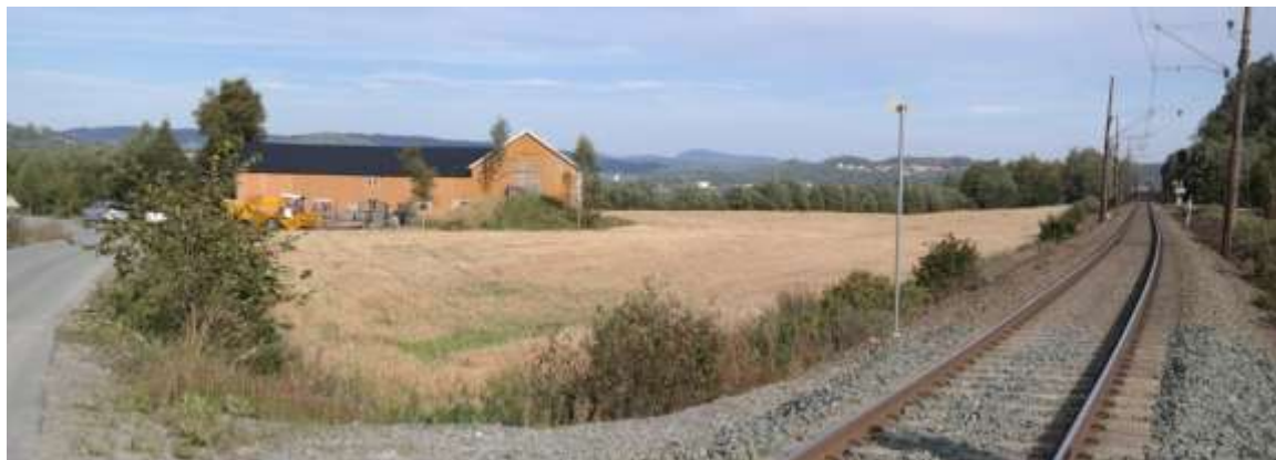
Figur 4-11 Foto av sentrale deler av terminalområdet for 2A og 2B ved planovergang over dagens Dovrebane ved Hofstad gård
