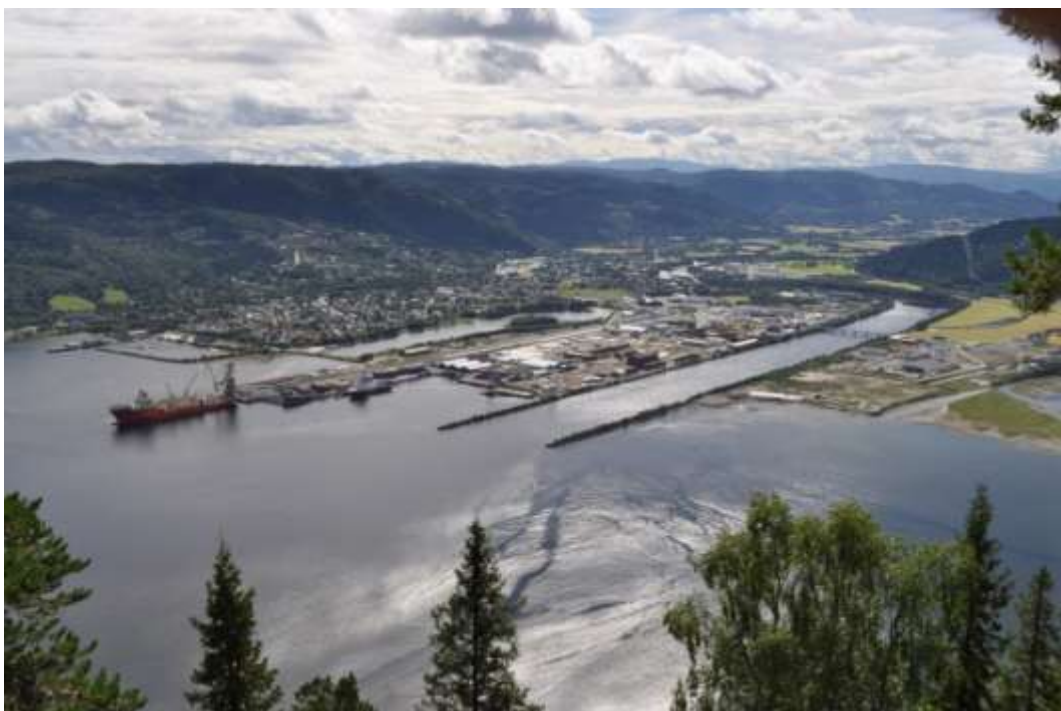
Figur 3-13 Foto Orkdal havn. Grønøra øst til venstre i bildet og området for ny havn på Grønøra vest til høyre, og til høyre for utløpet av elva Orkla.
