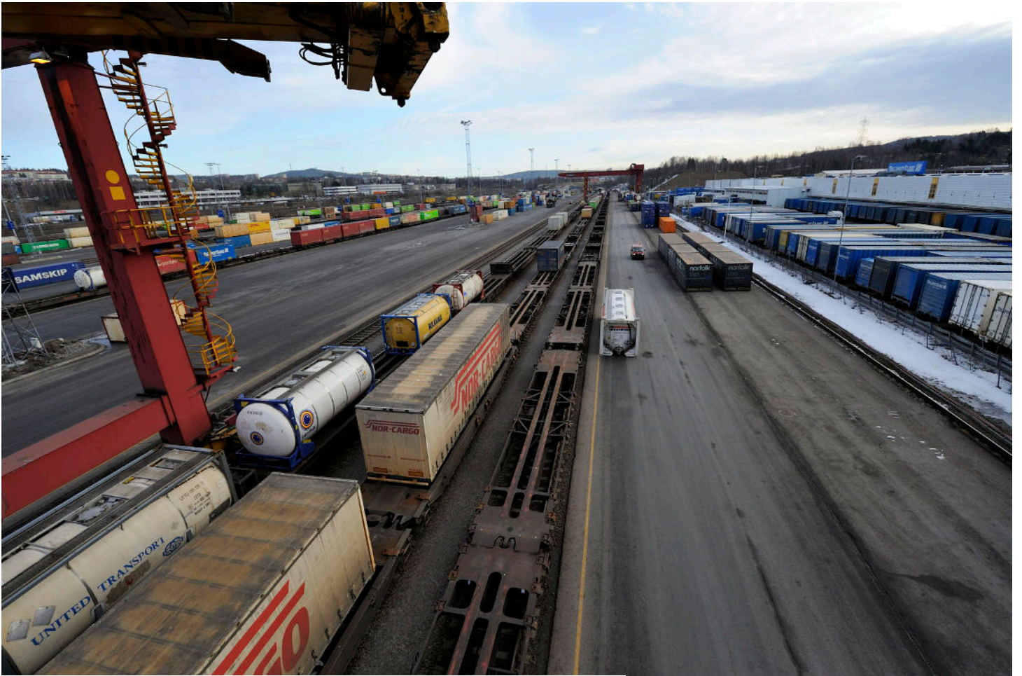
Lastespor nord på Alnabru godsterminal. Foto: Øystein Grue
