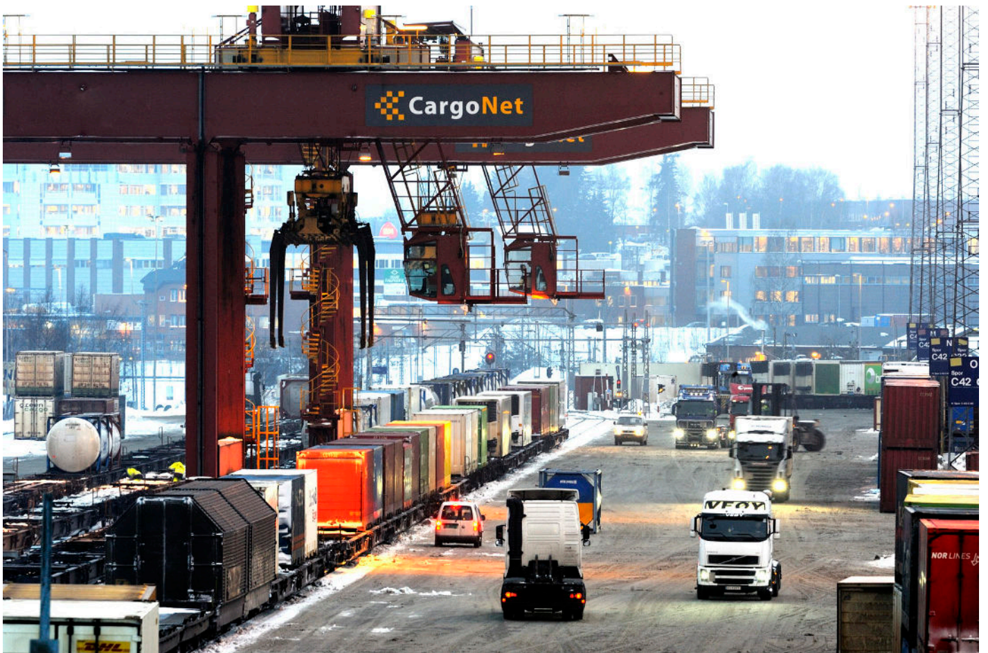
Lastespor med kran nord på Alnabru godsterminal. Foto: Øystein Grue
