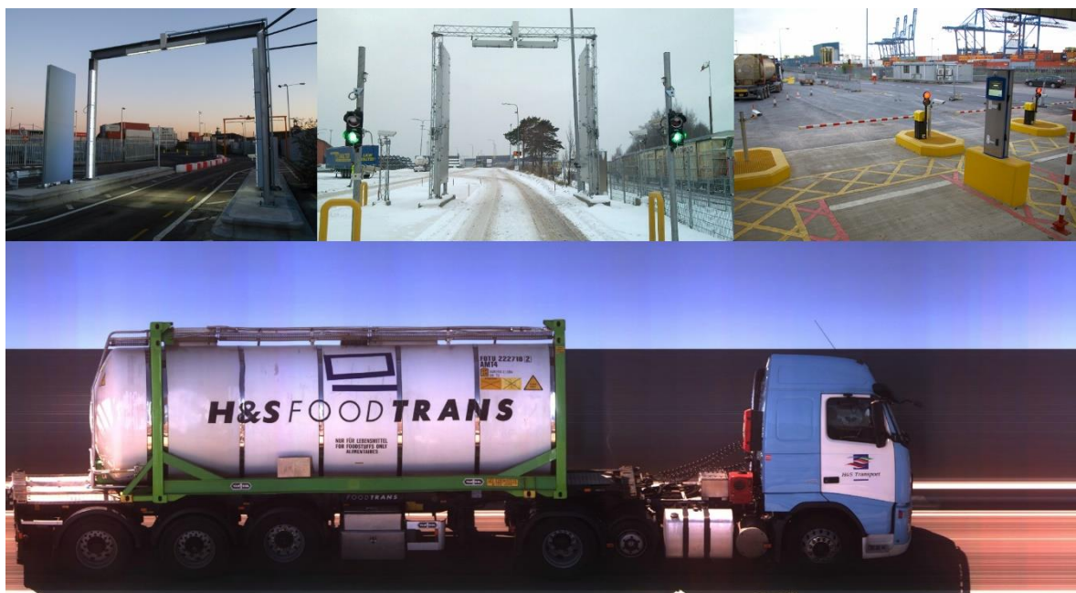
Figur 27 - Eksempler på gatesystem til kombiterminal og skanning
