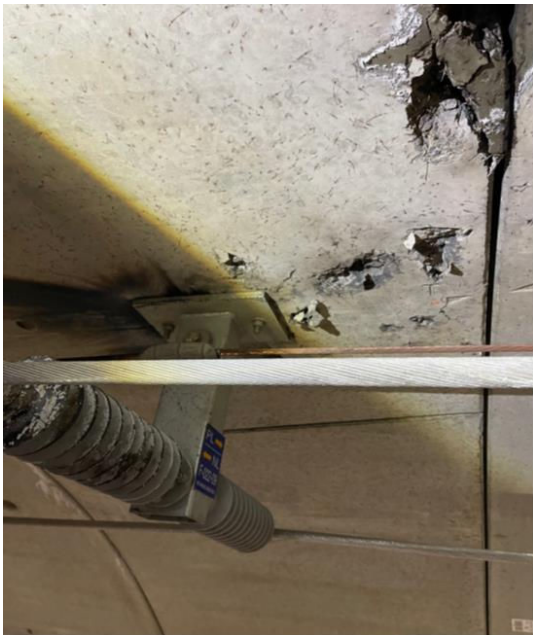
Bilde nr.3.: Skade på isolator og betonghvelv
