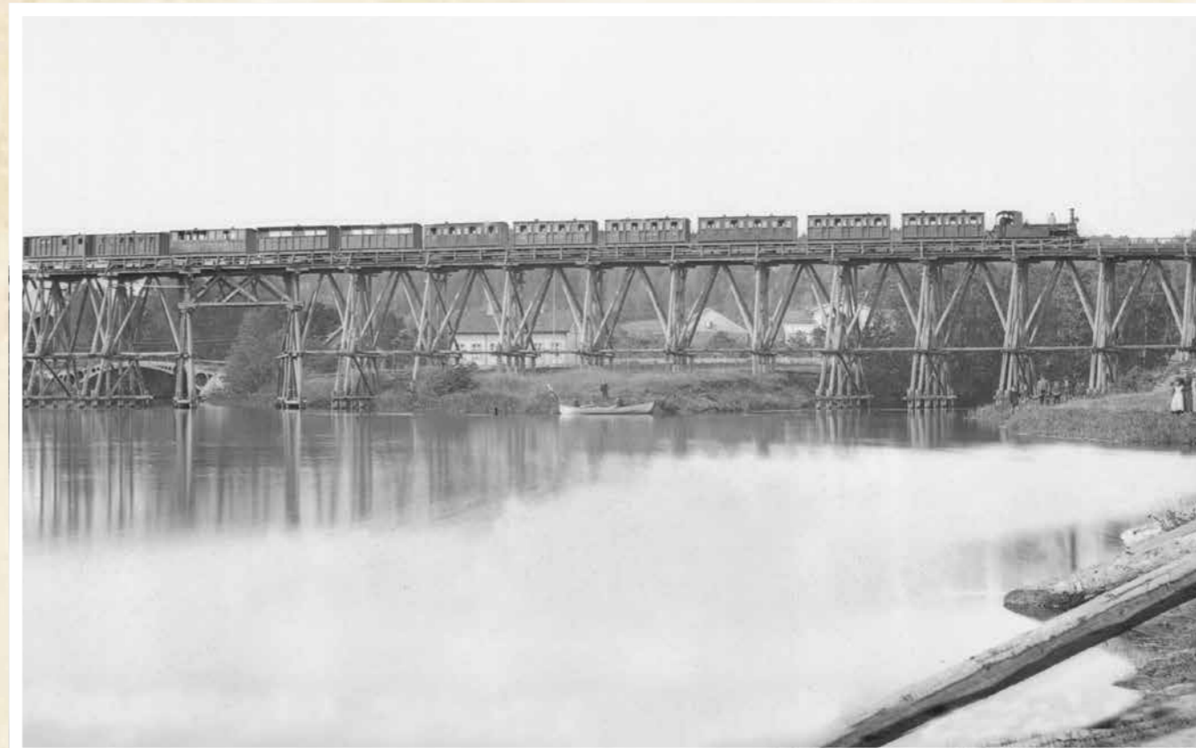
I 1873: Fra Christiania–Drammenbanens første tid. Et langt persontog poserer på Sandvikabrua om lag et år etter åpningen i 1872. I 1888 ble denne peleåkkbrua erstattet av en jernbru.
