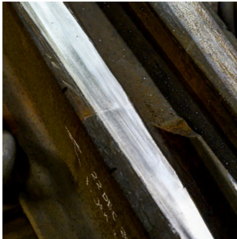
KRITISK: Utgangspunktet for nattens jobb er et nesten gjennomgående skinnebrudd i den mest kritiske delen av et sporkryss i Oslostunnelen.
