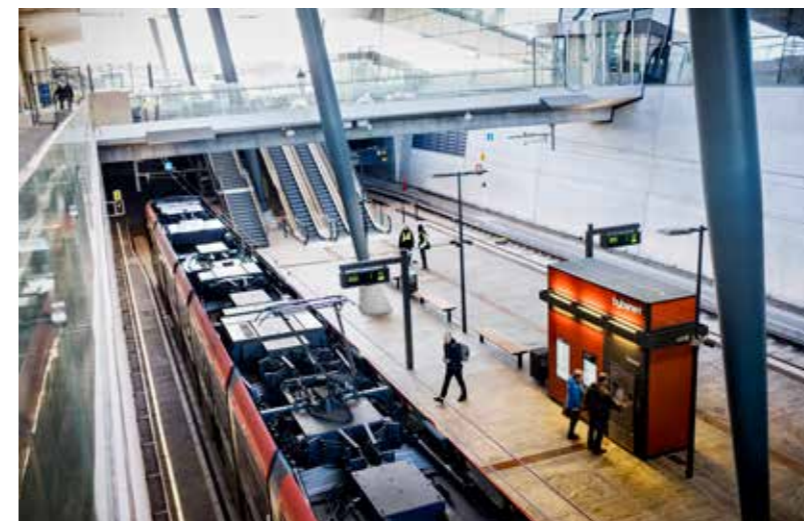
SISTE STOPP: Bybanens endeholdeplass på Flesland ligger rett under den nye terminalen, som åpner i august.
