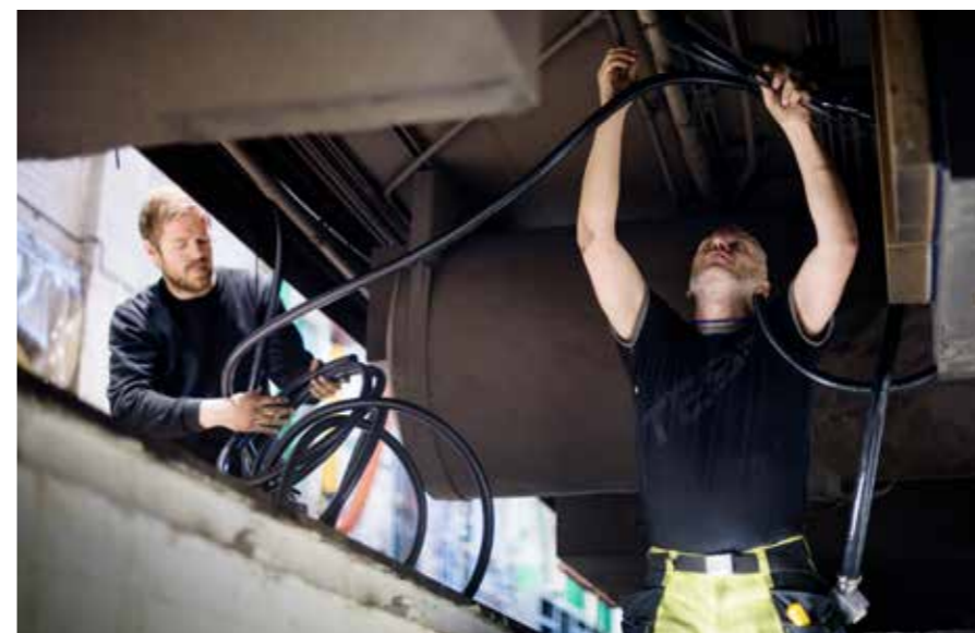
KABLER: Mye arbeid har skjedd under vognene, blant annet for å sikre kraftigere strømtilførsel. Her er Paul Schiager og Ståle Stenhaug fra Mantena i arbeid under F7-en, det vil si regi-vogna.
