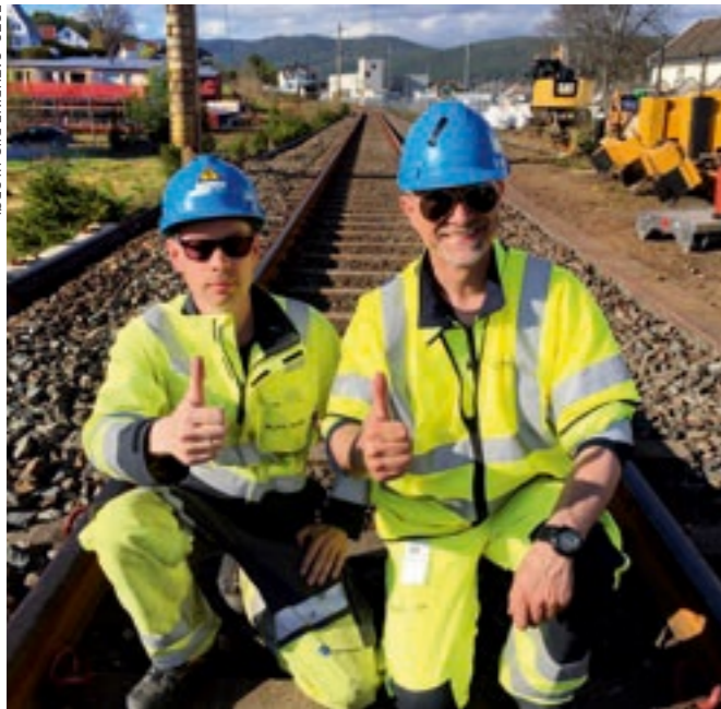
GODT FORNØYDE: Byggeleder Knut Hvila Solhaug (t.v.) og prosjektleder Lars Christen Kile i Bane NOR var ansvarlig for skinnabyttet sør for Kongsberg stasjon.
