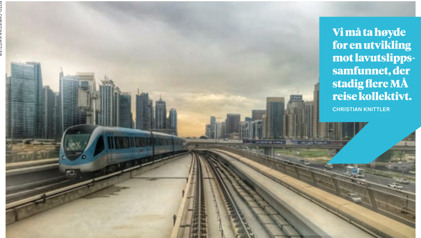
FERDIG STØPT: Når det bygges jernbane, bør det bygges stort nok. En ny ombygging før infrastrukturens levetid er nådd, betyr at vi får mindre jernbane for pengene. Bildet er tatt på Dubai metro.
