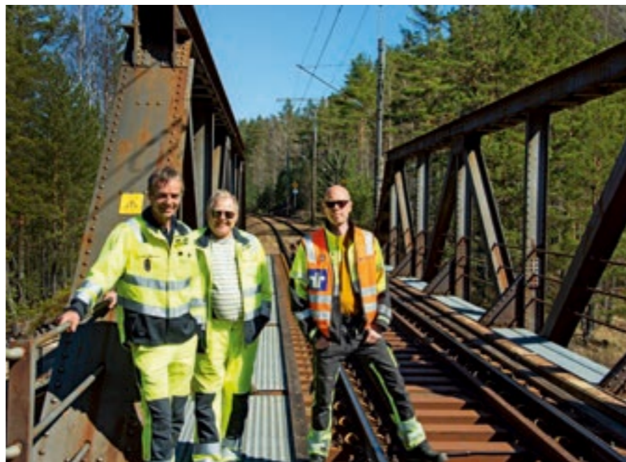
BRUFORNYERE: Fra venstre Arne Bujordet, Ingar Uldal og Knut Solhaug på bru over Retelva ved Fidjetun. Brua er eneste sted i landet det gjøres forsøk med sviller av kompositt. Vellykket, men for dyre sviller er dommen så langt.
