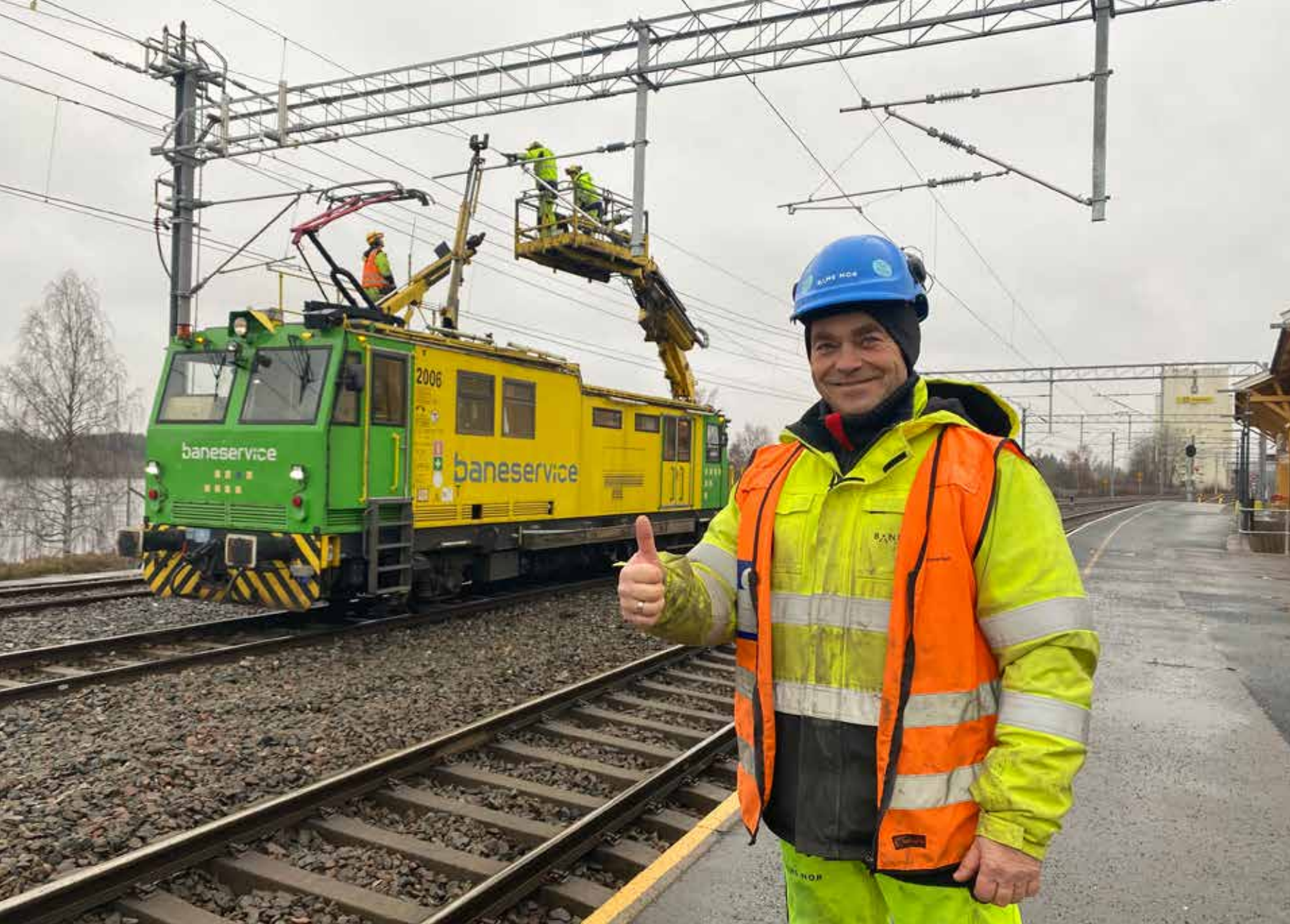
↑ NY TID: Byggeleder Odd Roar Tjosevik i BaneNOR gir tommel opp på Kongsvingerbanen etter at strømforsyningsanlegget fra Lillestrøm til Åbøgen er oppgradert. Foto: Glenn Lund, BaneNOR.
