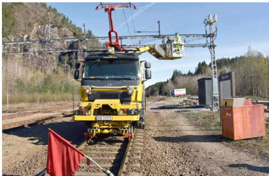
↑ BÅDE PÅ BANE OG VEG: Maskinene frå Nettpartner Bane kan køyre på både veg og bane og er fleksible i bruk ved arbeida på sørlandsbanen.
