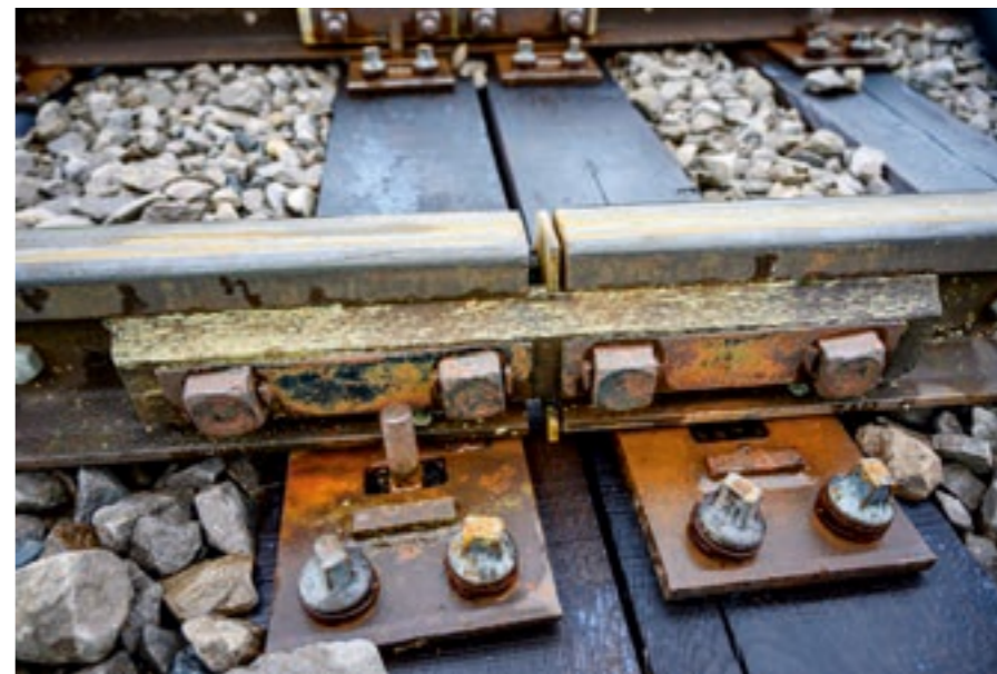
UTDATERT: Dagens system krever en rekke isolerte skinneskjøter og gir mange «signalfeil.»
