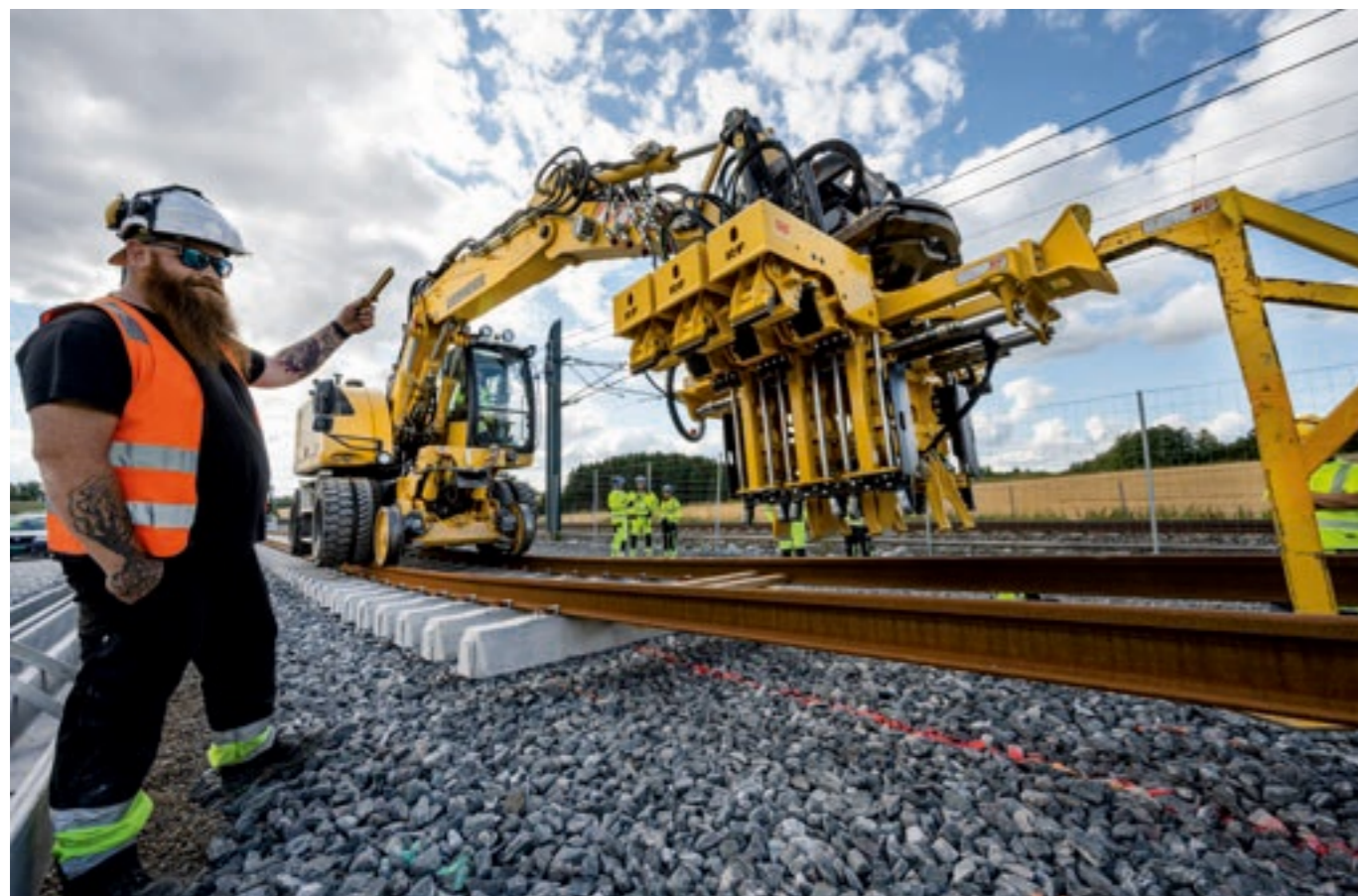
NYTT VERKTØY: Baneservice har ansvar for all jernbaneteknikken på nytt spor gjennom Eidsvoll. Leder el-sikkerhet, Geir Gerhardsen, følger med når det nye hydrauliske enmanns-betjente svilleleggerverktøyet, som gjør det mulig bygge 480 meter spor på ett skift, er i sving.
