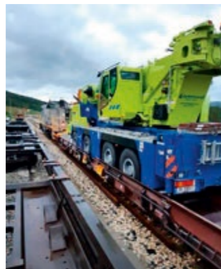
PÅ FLATVOGN: Her er en stor mobilkran lastet opp på flatvogn bak en Di8 for transport inn til en godstogavsporing på Nordlandsbanen i fjor sommer.
