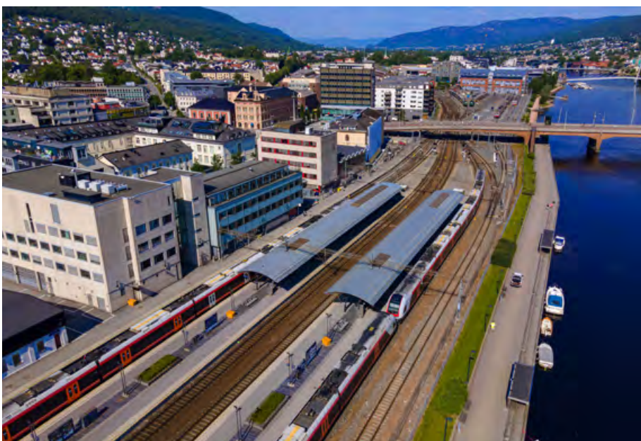
↑ DRAMMEN STASJON: I byggeperioden på over to år skal halvparten av togtrafikken på Drammen stasjon bort. Tre av seks spor vil hele tiden være i bruk. Foto: Nils Maudal
