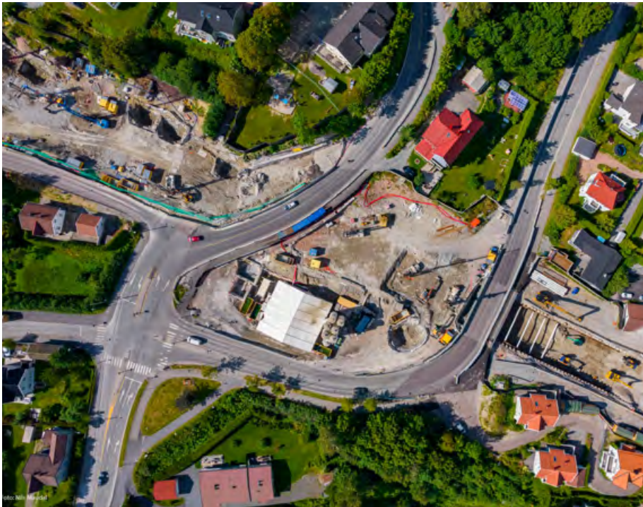
↑ OMBYGGINGER: Veier må legges om og bruer bygges for å få plass til anleggsarbeidene i Drammen. Foto: Nils Maudal
