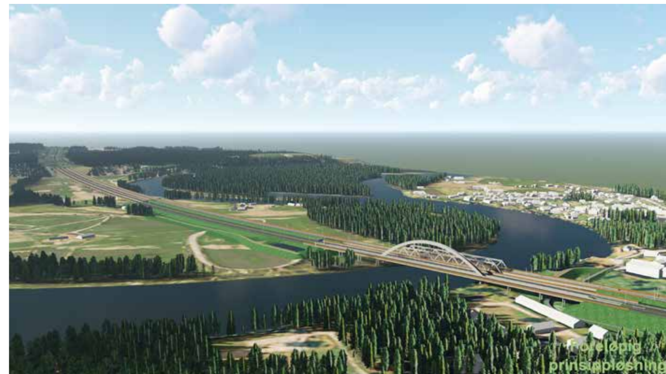
... ELLER TO BRUER MED FYLING? Prosjektet gjennomfører omfattende grunnundersøkelser for både pæling og eventuell fylling.
