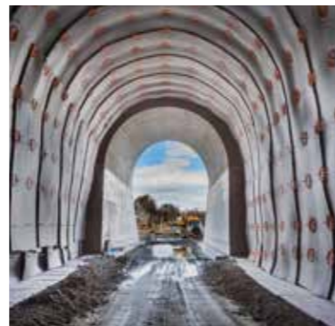
TUNNEL: Ofofbanen har fått det femte nye kryssingssporet. Bildet viser tunnelarbeidet på Djupvik.
