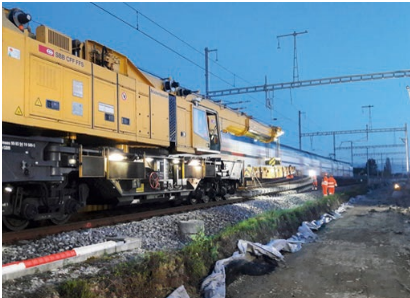
PENDELTOG: I stedet for å stenge banen kjører SBBs store pendeltog hvert kvarter på den ene sporet mens det andre fornyes.
