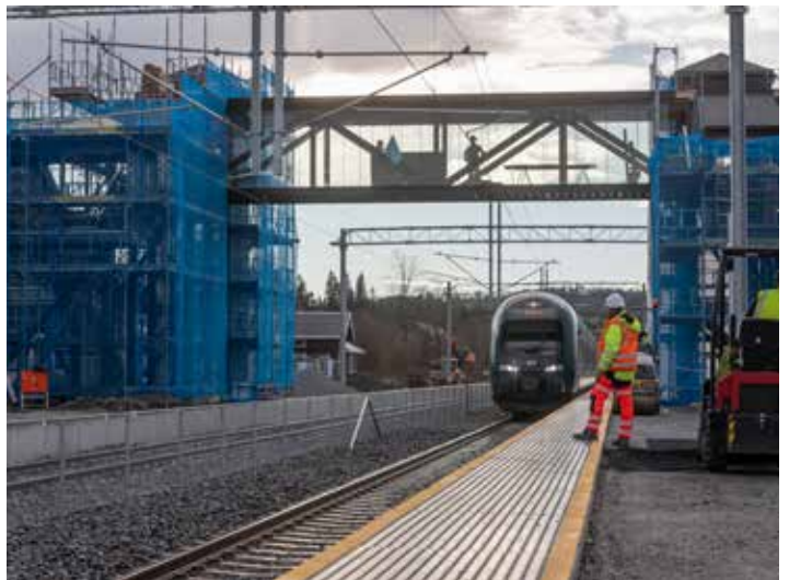
↑ REINSVOLL STASJON gjennomgår for tiden store endringer. Der bygges det både nytt kryssingsspor og overgangsbru med heiser. Kryssingssporet er nødvendig for å kunne kjøre timesavganger til og fra Gjøvik.
