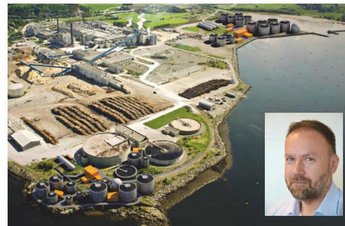
FIBORGTANGEN: Norske Skog ble etablert på Fiborgtangen på 1960-tallet. Nå er området i ferd med å bli en industripark. Tankene i forgrunnen er bioreaktorene som skal produsere gass og gjødsel av avløpsvann og selvdød fisk. Alle-rede nå ser Biokraft for seg enda ett byggetrinn. Da kan det bli aktuelt å bruke sidesporet som går gjennom området.
