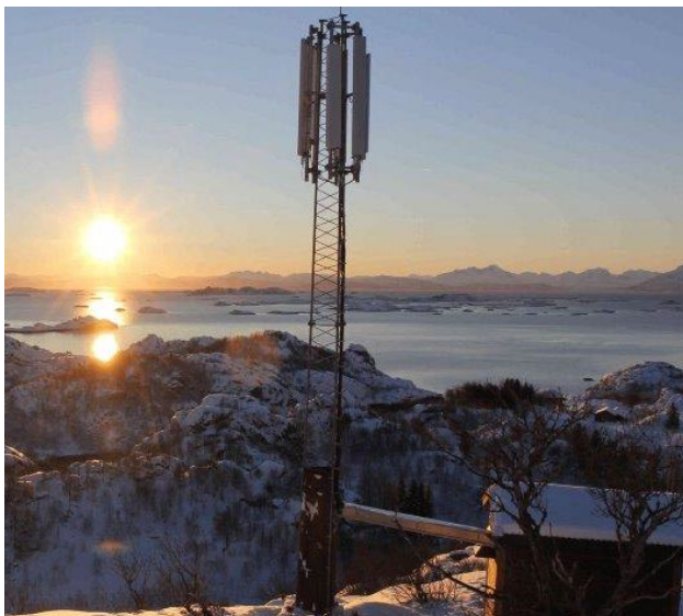
Figur 2-5. Basestasjon. Kilde: Telenor
