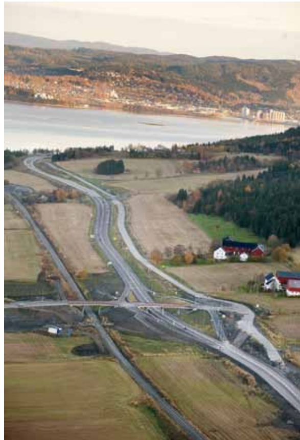
Figur 52: E6, lokalveg og bane parallelt, Vist - Frøset (Kilde: Statens vegvesen)
