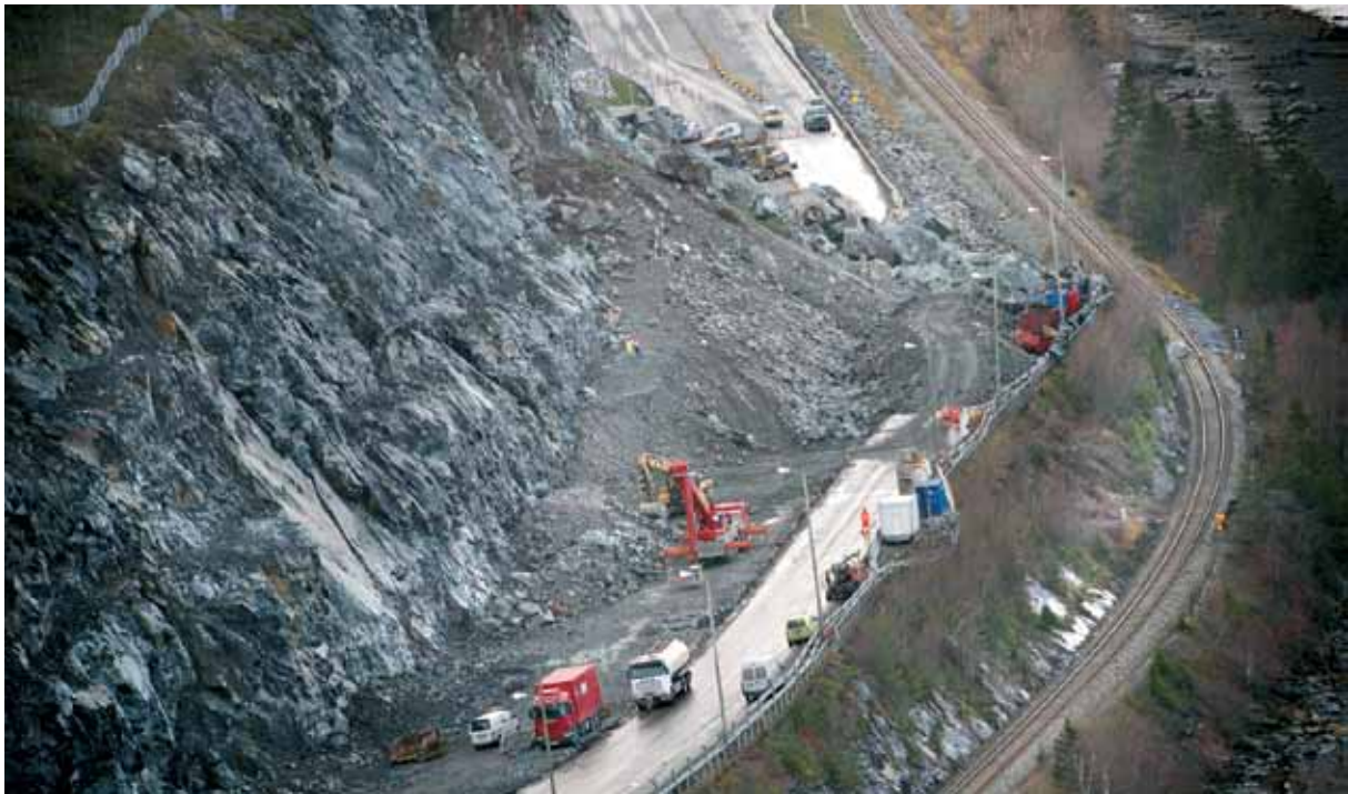
Figur 15: Nærføring av veg og bane i sårbart område ved Løsberga (Statens vegvesen 2008)
