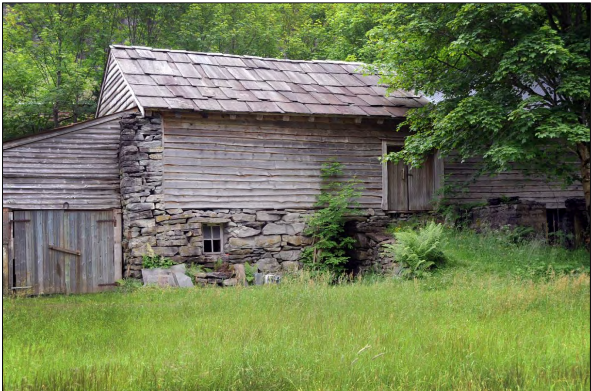
Figur 29 Driftsbygning på Dalegarden, Vaksdal kommune. Dagsone F. Foto: A. Østerdal, Statens vegvesen.
