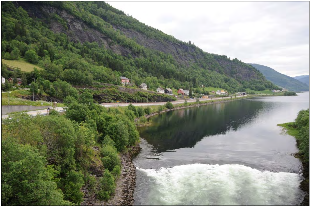
Figur 24 Utløpet av Vangsvatnet ved Lilandsosen. Eit viktig gyteområde for villaks, men delvis øydelagt under senkinga av Vangsvatnet på slutten av 80 talet. Dagsone A. Foto: A. Østerdal, Statens vegvesen
