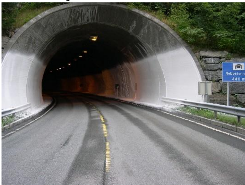
Figur 12. Kvitkalking i tunnel.
