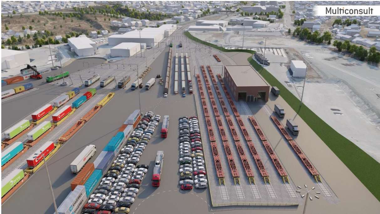
Figur 18. Verksted, hensetting og bilterminal sett nordover mot Heimdal stasjon.
