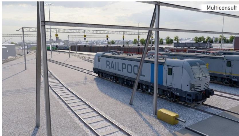
Figur 41. Dvergsignal og markerboards montert hengende fra åk.
