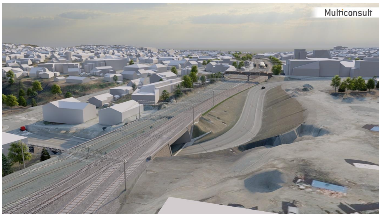
Figur 15. Ny sporplan Heimdal stasjon, sør ved Johan Tillers veg. Bildet er sett mot nord.
