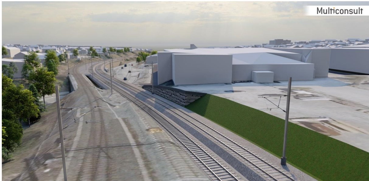
Figur 16. Eksisterende jernbanebru og planlagt dobbeltsporet jernbanebru, sett retning nord.
