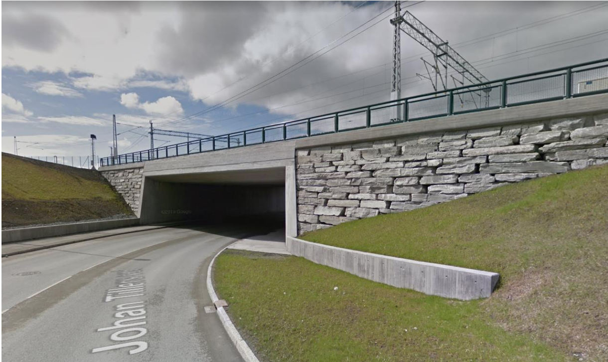
Figur 24. Eksisterende vegkulvert for Johan Tillers vei, sett fra østsiden (Google Maps).
