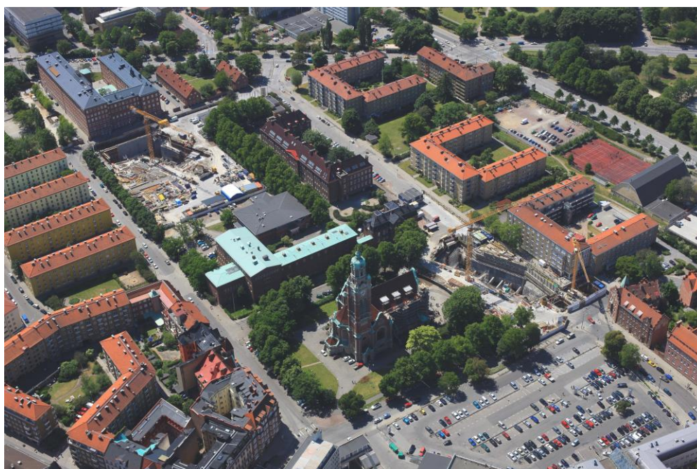
Figur 10: Byggegrøp for Citytunnelen i Malmø (Foto: Perry Nordeng/Citytunnelen)
