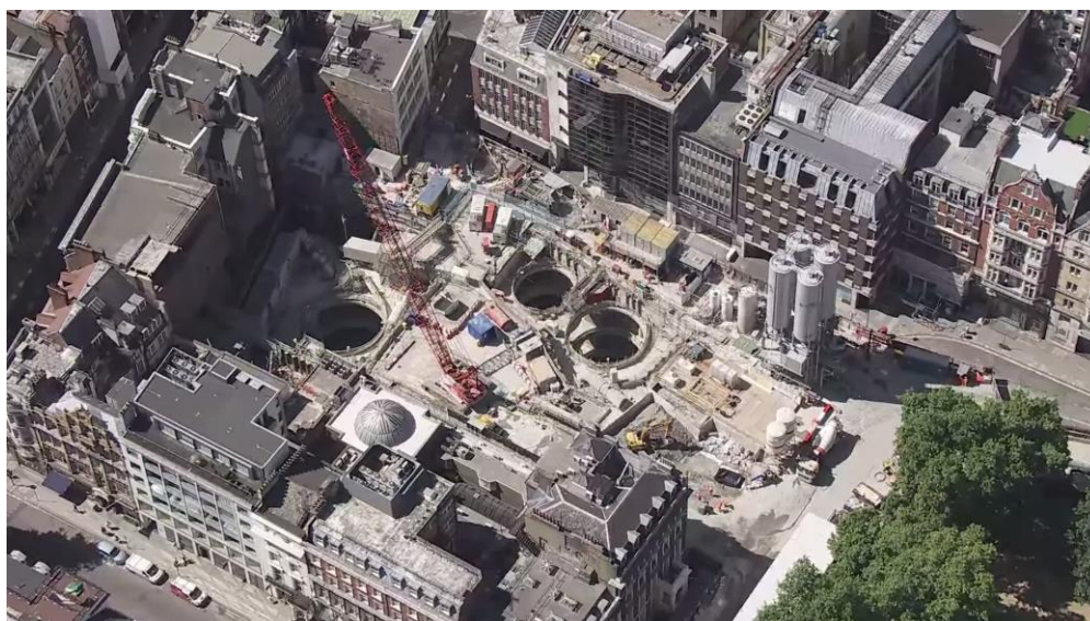
Figur 9: Byggegrøp for CrossLink i London (Foto: www.crossrail.co.uk )
