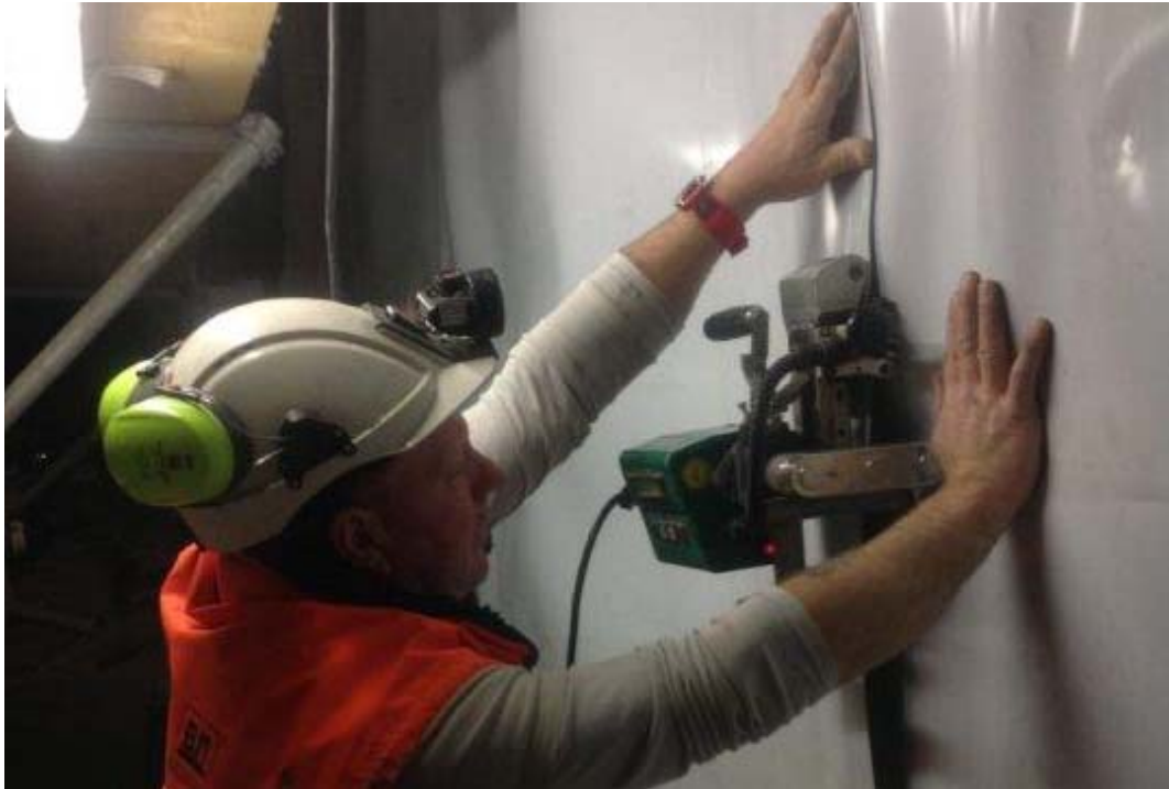
Figur 11: Sveising av membranskjøt i Ulvintunnelen. Fellesprosjektet E6-Dovrebanen
