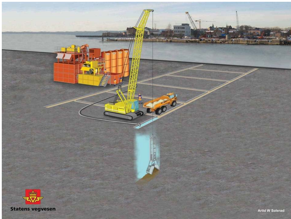
Figur 29: Slissevegger - graving av grøft (Illustrasjon: SVV)
