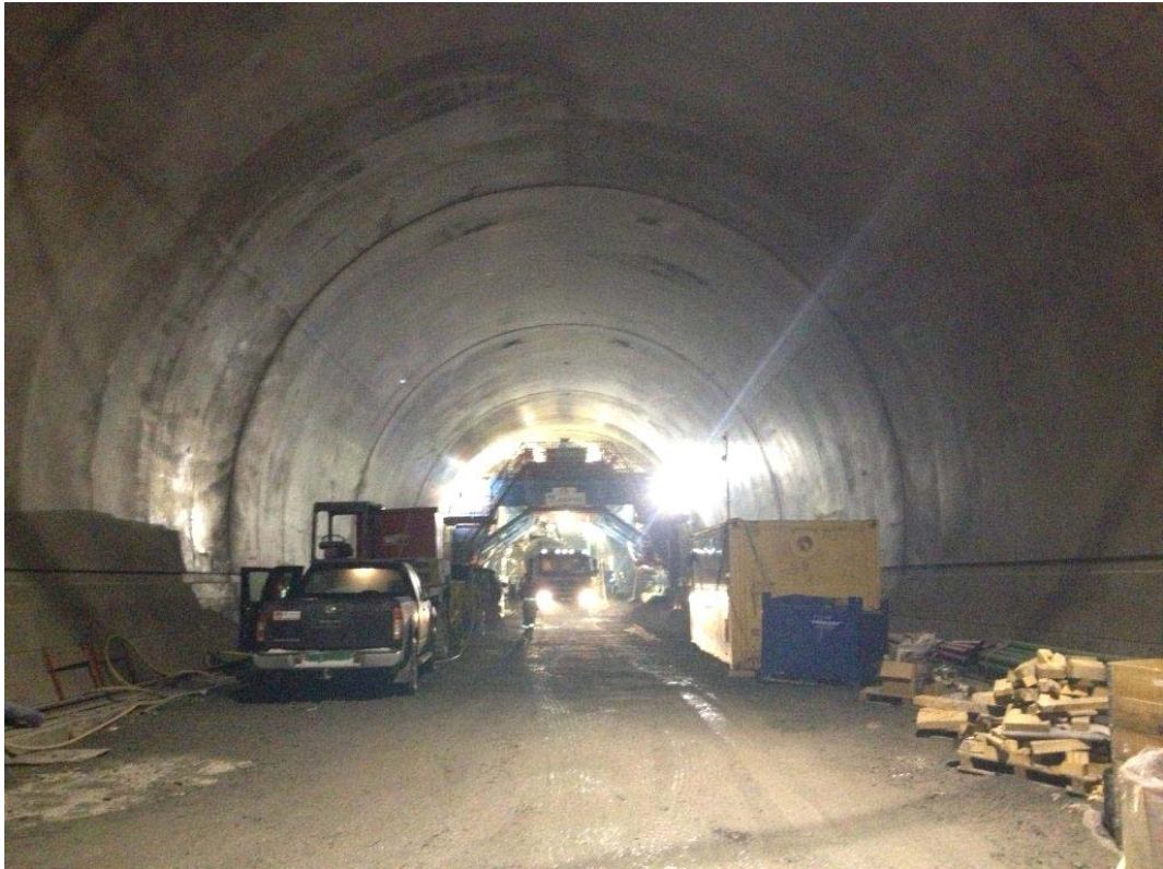
Figur 13: Ferdig kontaktstøpt betonghvelv i Ulvintunnelen. Fellesprosjektet E6-Dovrebanen
