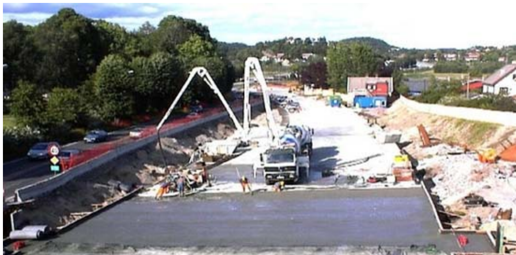
Figur 35: Oddernestunnelen. (Foto: www.veidekke.no )
