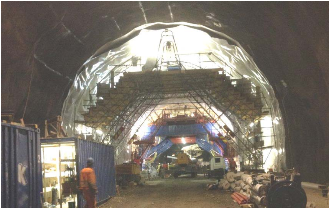
Figur 10: Montering av membran i Ulvintunnelen. Fellesprosjektet E6-Dovrebanen
