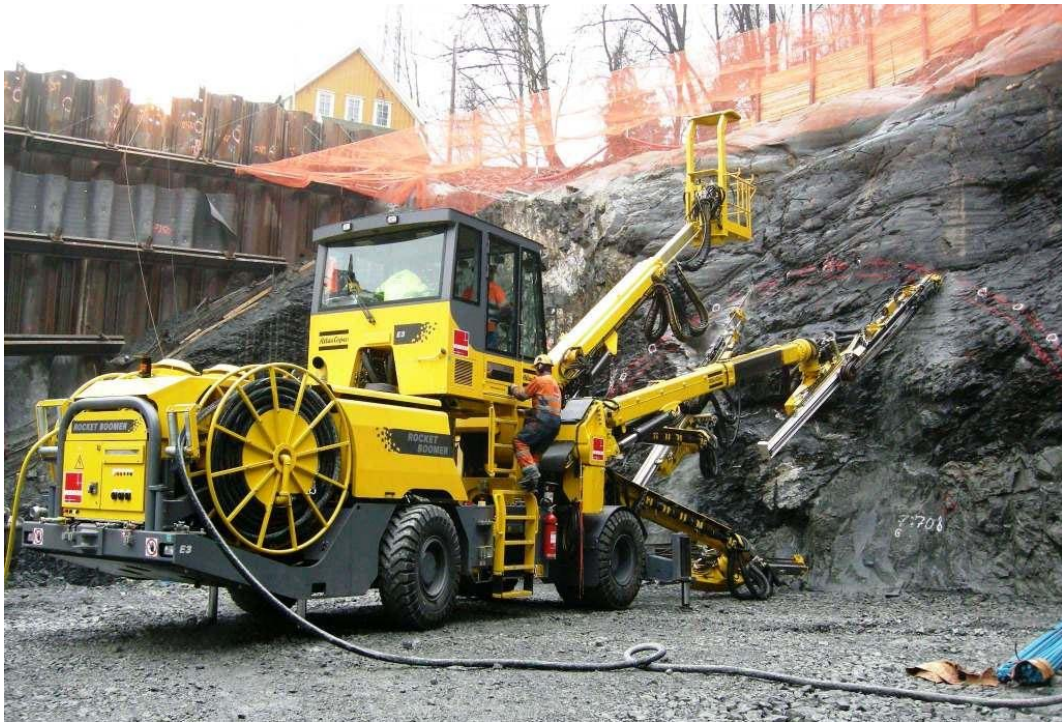
Figur 1: Tunnelborerigg i arbeid ved påhugg for Bærumstunnelen på Lysaker Vest
