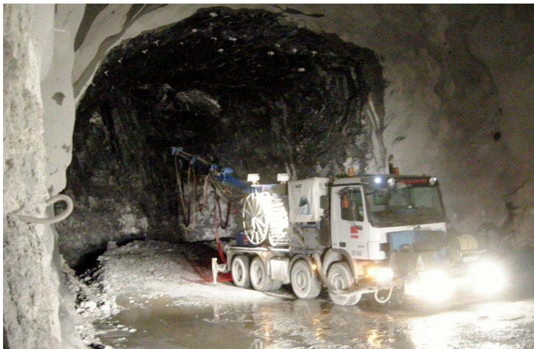
Figur 4: Sprøytebetongbil under arbeid i Bærumstunnelen
