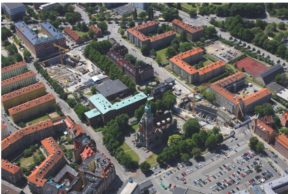
Figur 9: Byggegrøp for Citytunnelen i Malmö. (Foto: Perry Nordeng/Citytunnelen)
