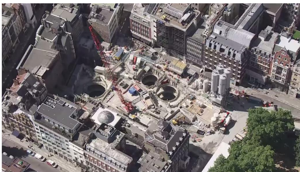
Figur 8: Byggegrøp for CrossLink i London. (Foto: www.crossrail.co.uk )
