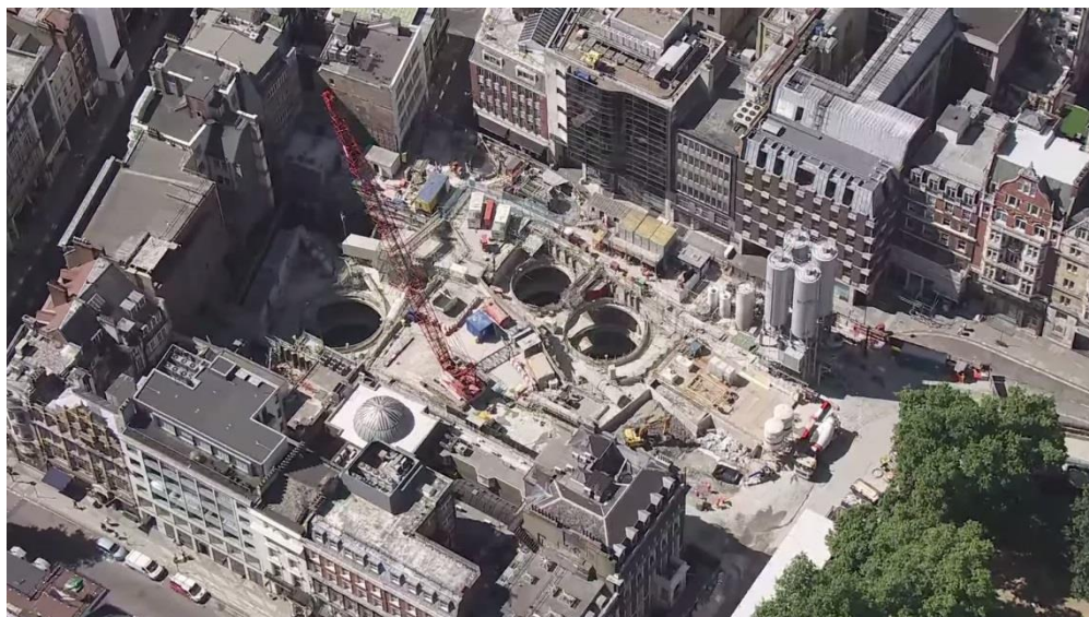
Figur 4: Byggegrøp for CrossLink i London. Foto: www.crossrail.co.uk
