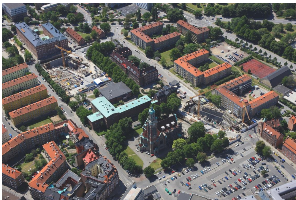
Figur 5: Byggegrøp for Citytunnelen i Malmø. Foto: Perry Nordeng/Citytunnelen
