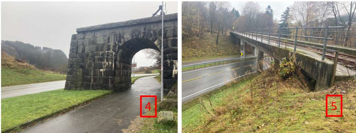
Figur 6-14: Bruer over fylkesveier (foto: Norconsult)
