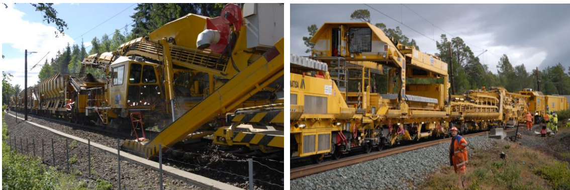
Figur 4-7 Ballastrenseverk (t.v.) og sporombyggingstog. Foto: Njål Svingheim
