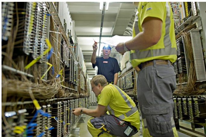
Figur 4-4 Kontroll av sikringsanlegg. Foto: Hilde Lillejord
