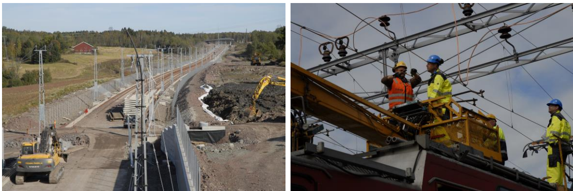
Figur 4-8 Arbeid med ny infrastruktur (t.v.) og arbeid med kontaktledningsanlegg. Foto: Njål Svingheim
