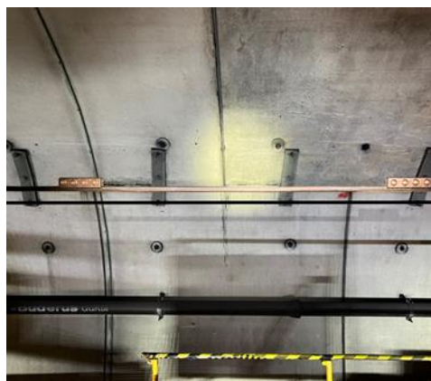
Bilde nr. 1.: Utbedret kontaktledning
