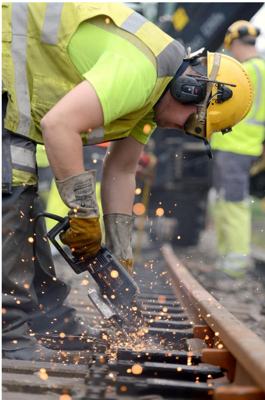
Bilde 1. Vedlikehold av sporveksel (Foto: Jernbaneverket)
