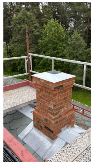
Ny pipe på godshuset. Foto: Øystein Bøe (NJM)
