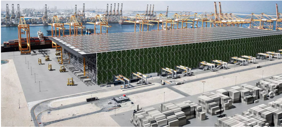
Figur 3-3. Automatisert høylager for containere BoxBay - DP World. Illustrasjon: SMS group GmbH
