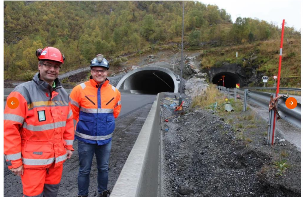
Arne Ola Stavseng og Ola Langset (bak), prosjektledere for Statens vegvesen og Skanska, har samarbeidet godt. God planlegging, god dialog og en stabil arbeidsstokk trekkes fram som suksessfaktorer for en vellykket prosjektgjennomføring for fylkesveg 60 Røyri–Hellesylt. Bilde: Kjell Herskedal
