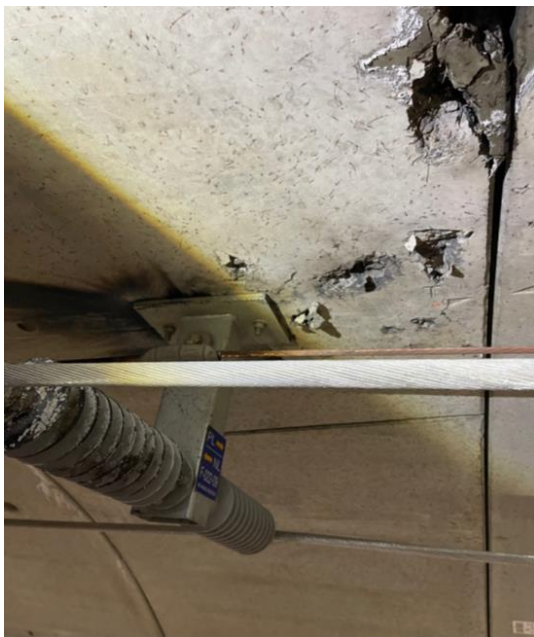
Bilde nr.3.: Skade på isolator og betonghvelv
