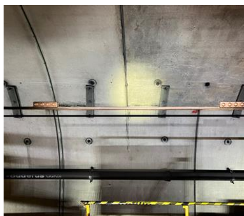
Bilde nr. 1.: Utbedret kontaktledning
